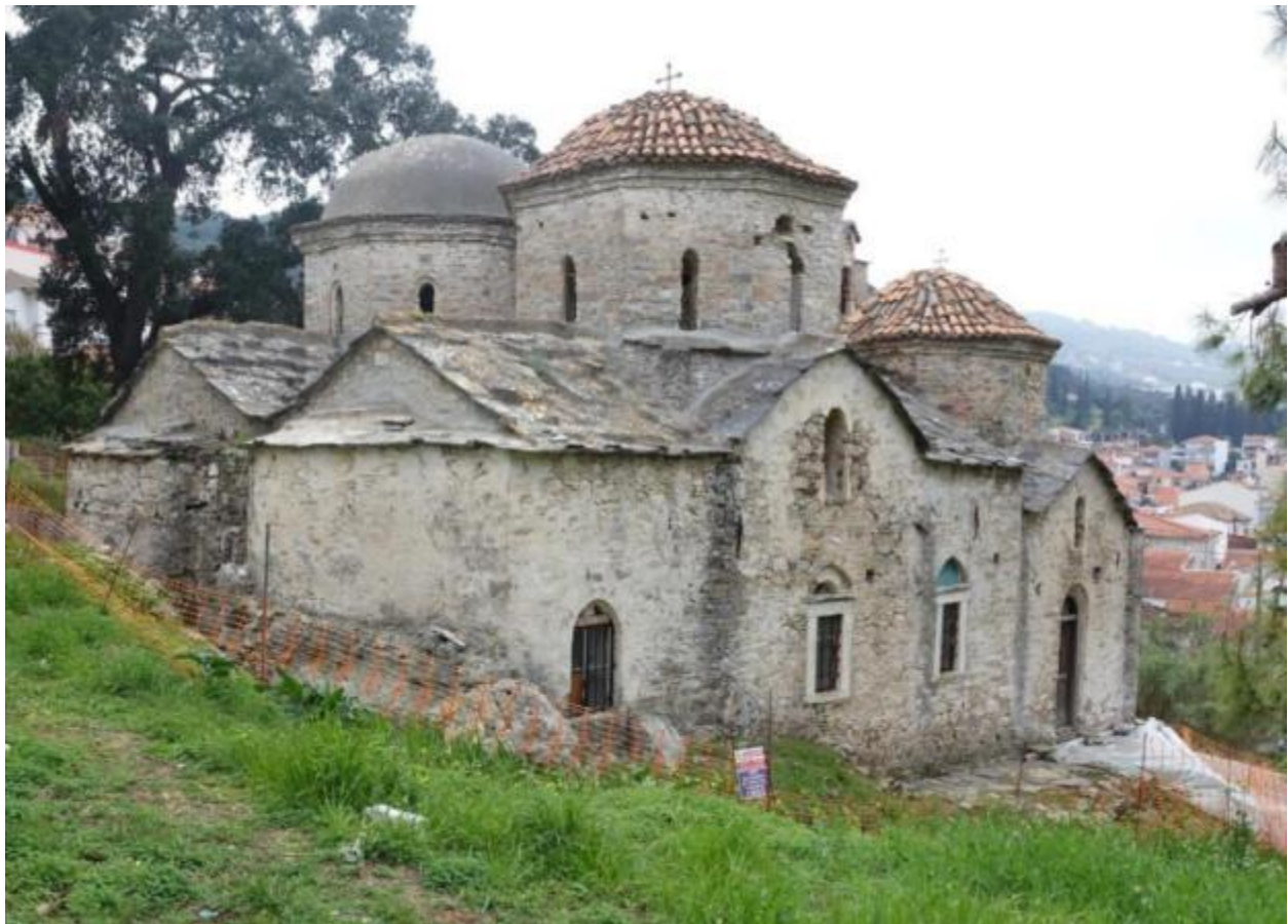
Εικόνα 08: Βορειοανατολική όψη του ναού πριν την έναρξη των εργασιών.
