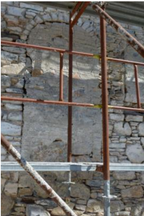
AN.17 Θύρα δυτικής όψης
