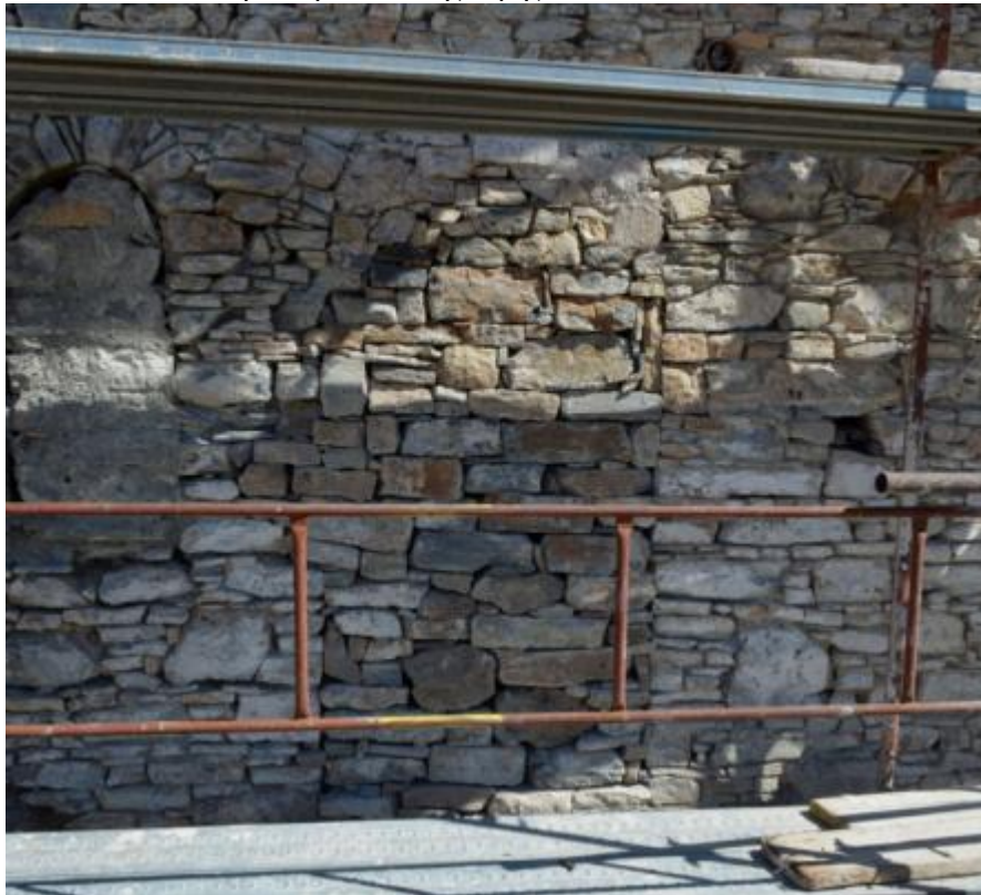
AN.20 Θύρα δυτικής όψης
