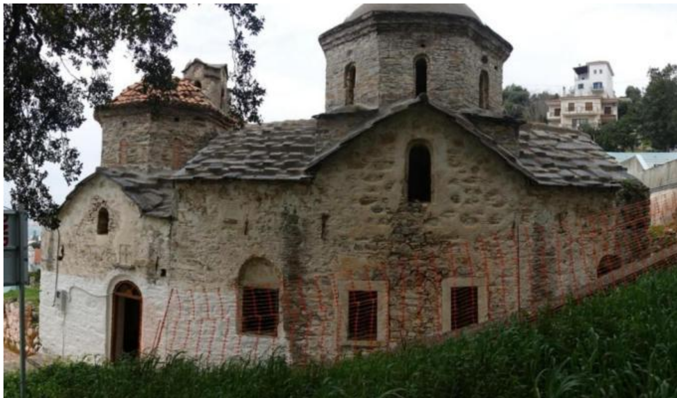
Εικόνα 04: Νότια όψη του ναού πριν την έναρξη των εργασιών.
