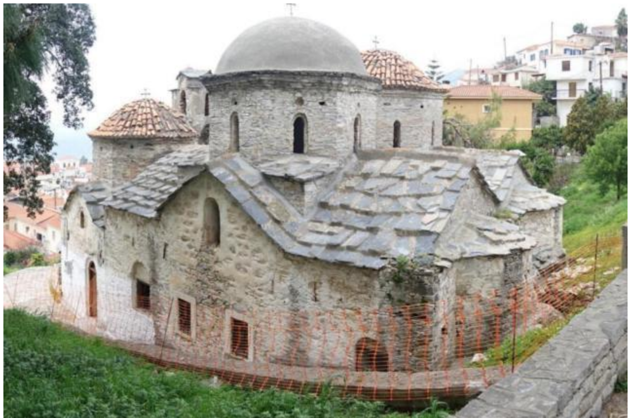
Εικόνα 06: Νοτιοανατολική όψη του ναού πριν την έναρξη των εργασιών.
